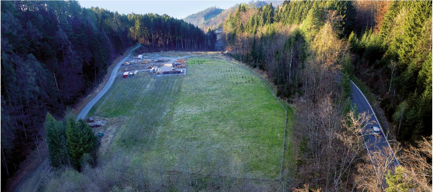
Deponie Malons, von Süden aus betrachtet. Foto: Gemeinde Röthis/Dietmar Mathis
